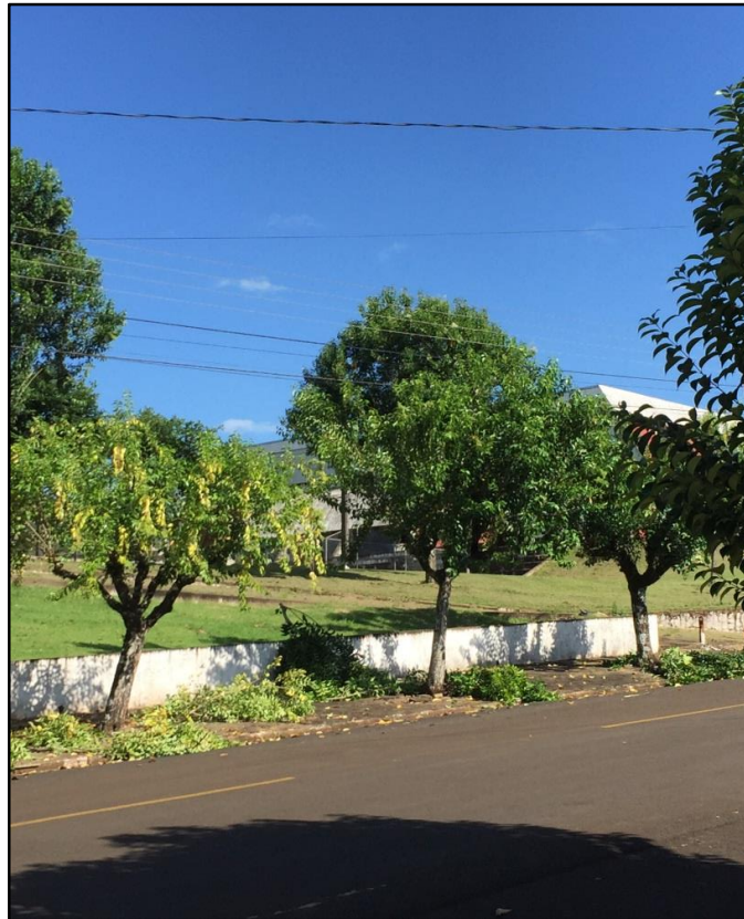
Figura 17 – Árvore em conflito com a rede elétrica.
