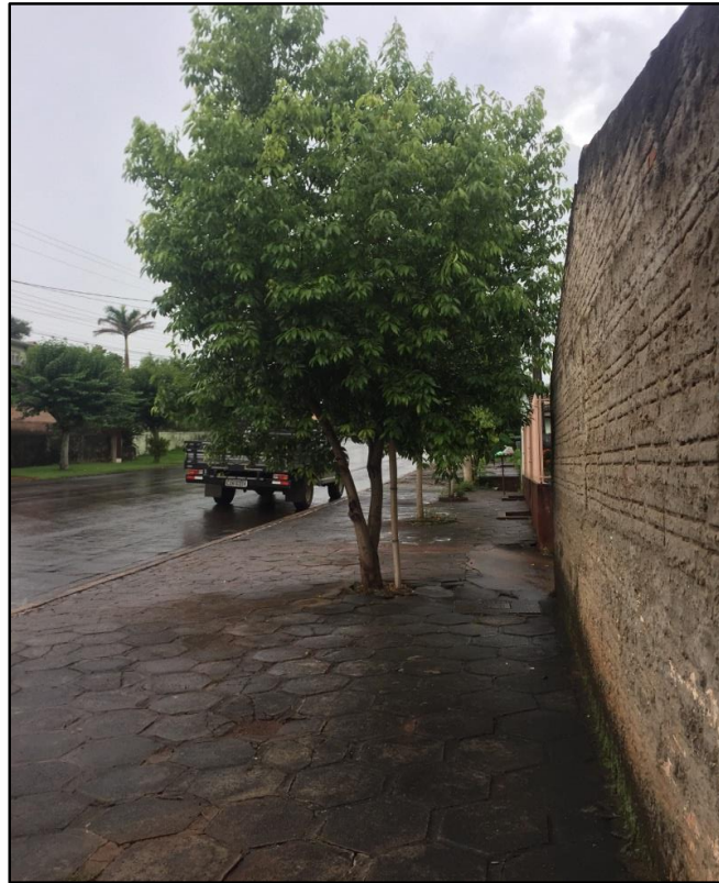
Figura 20 – Árvore com falta de manejo, interferindo no trânsito de pedestres.
